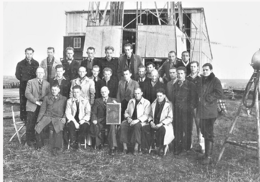
Boorpersoneel van de Bataafse Petroleum Maatschappij bij een boring. Exacte locatie en jaartal niet bekend.
