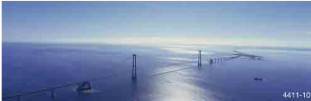
Fig.2 Brug over de Grote Belt, Denemarken. Lengte overspanning 1624meter.
